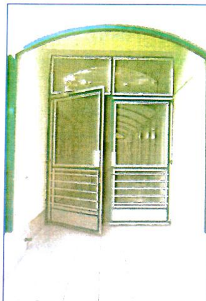
vstup do objektu II.stupně
