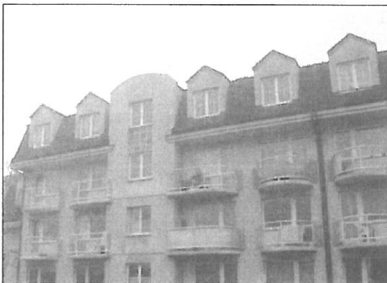
Foto /1/ Pohled na střechu předmětného BD.
