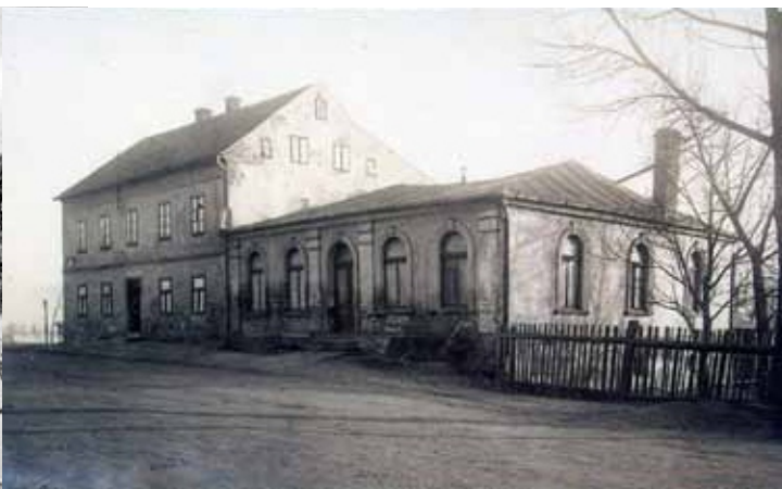
Počerny, dům č. 47 patří k parní cihelně – foto z roku 1906
