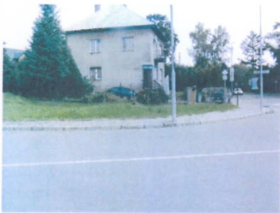
Obr. A2 – Chybějící přechod pro chodce přes ul. Partyzánská
