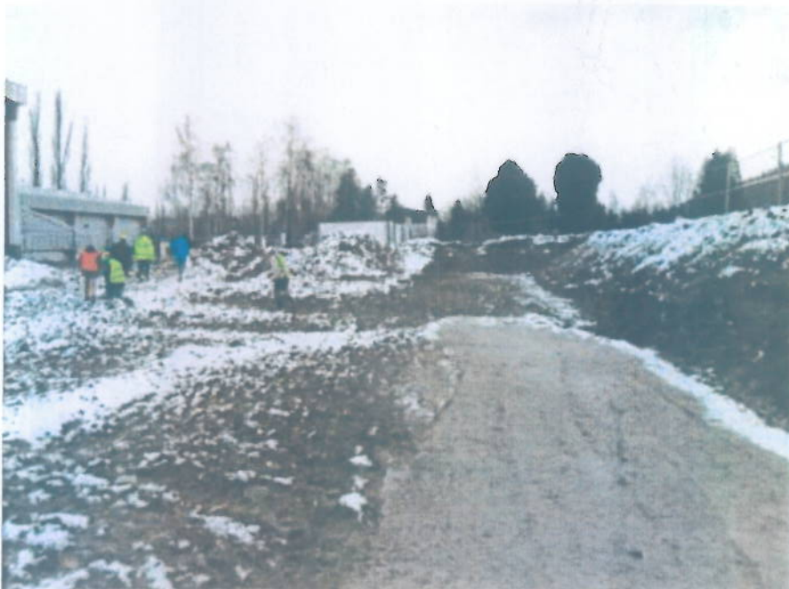
Pohled na část zhutněné pláně pod OP1
