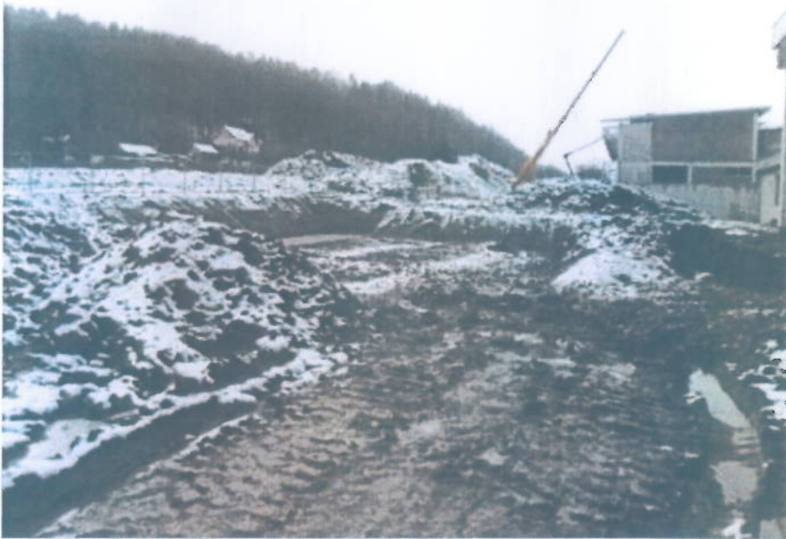
Pohled z příjezdové komunikace (od severovýchodu)
