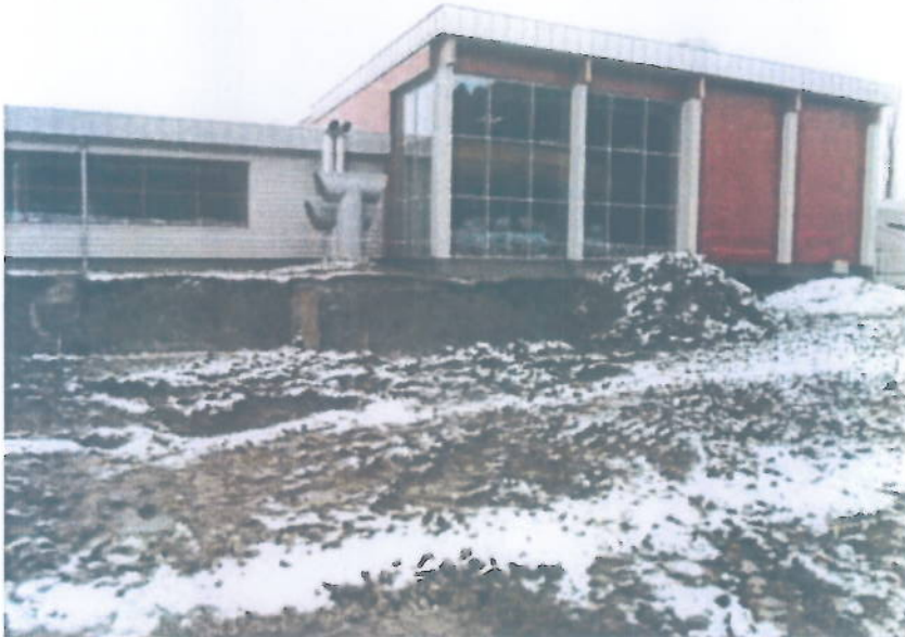
Pohled směrem ke stávajícímu objektu krytého bazénu
