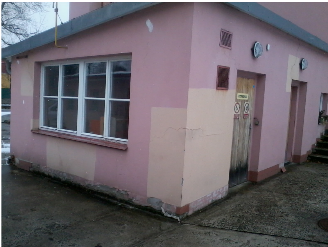
Foto 9 – severovýchodní fasáda - kotelna
