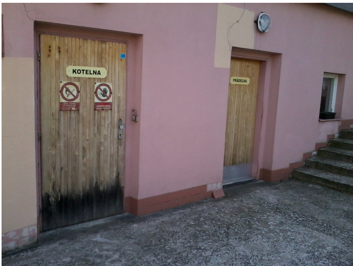
Foto 10 – severozápadní fasáda – vstupy kotelna, prádelna
