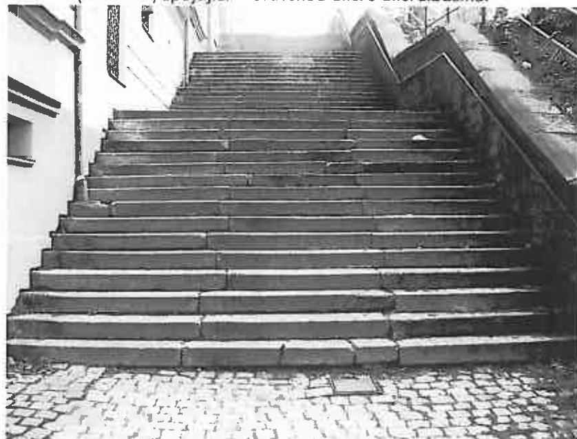
Schodiště a opěrná zeď (ozn. 372) spojující Moravskou ulici s ulicí Libušina.
