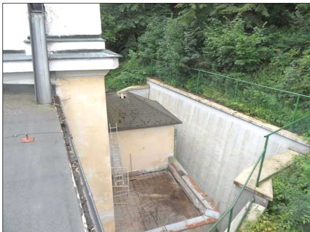
Foto /29/ Střecha 7 - Pohled na střechu (v administrativní sekci budovy)
