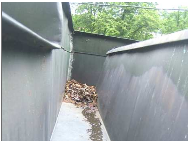
Foto /5/ Střecha 1 – Pohled do zaatikového žlabu střechy
