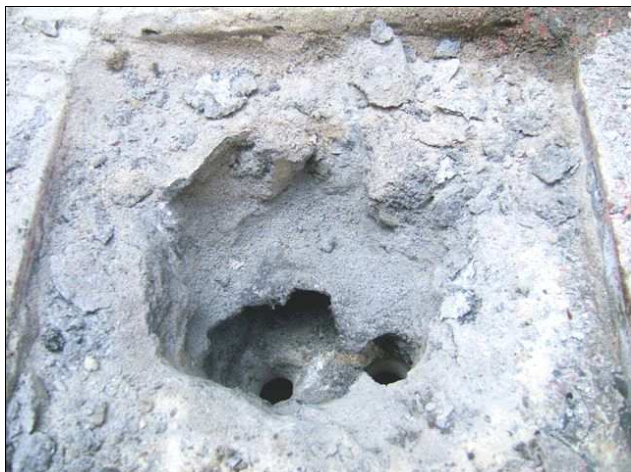
Foto /37/ Střecha 9 - Pohled na sondu do skladby terasy
