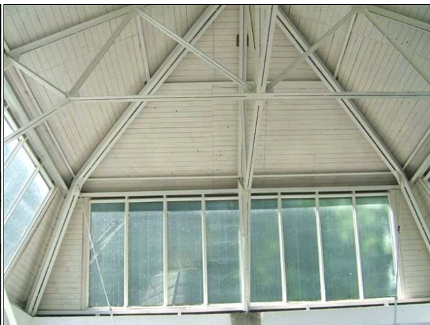
Foto /14/ Střecha 3 - Pohled na spodní stranu horního pláště střechy
