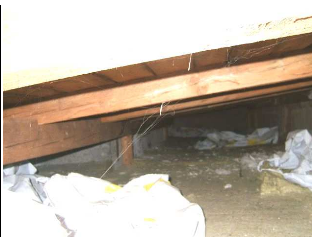
Foto /8/ Střecha 2 - Pohled do mezistřešního prostoru střechy
