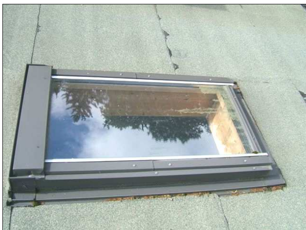
Foto /28/ Střecha 6 – Střešní okno podstřešního bytu
