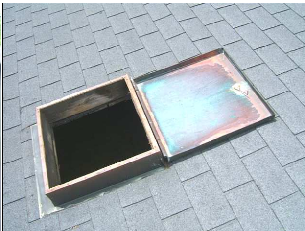
Foto /6/ Střecha 1 – Střešní výlez
