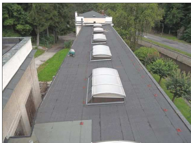
Foto /7/ Střecha 2 - Pohled na střechu - východní křídlo budovy
