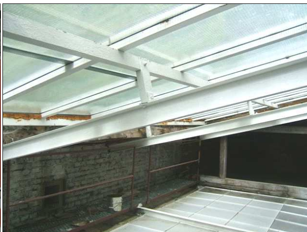
Foto /19/ Střecha 4 - Pohled do půdního prostoru střechy v prostoru světlíku
