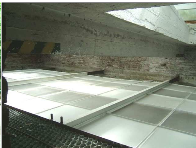
Foto /23/ Střecha 5a - Pohled do mezistřešního prostoru střechy v okolí světlíku
