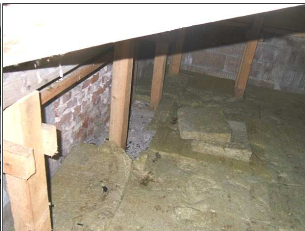
Foto /4/ Střecha 1 - Pohled do půdního prostoru střechy
