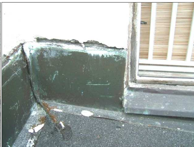
Foto /10/ Střecha 2 – Detail napojení střechy na přilehlou stěnu a okenní parapet
