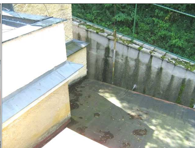
Foto /34/ Střecha 8 - Pohled na střechu
