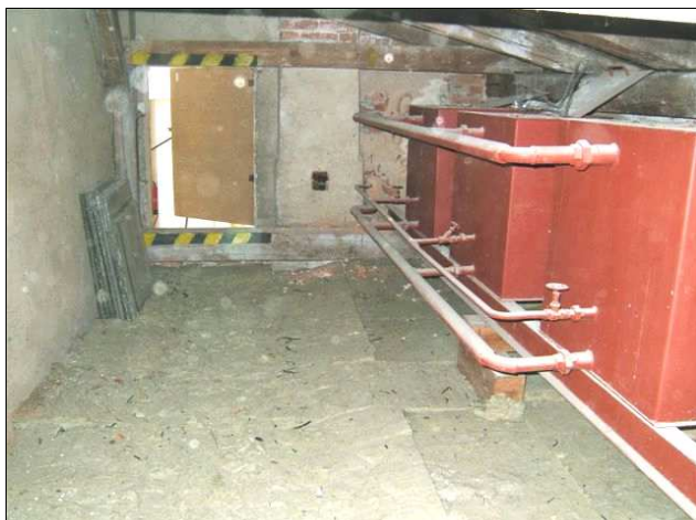
Foto /18/ Střecha 4 - Pohled do půdního prostoru střechy
