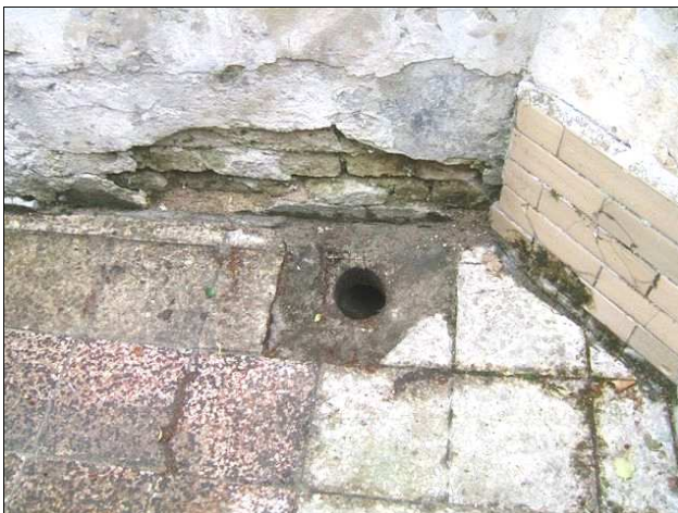
Foto /38/ Střecha 9 - Vtok
