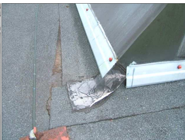
Foto /12/ Střecha 2 – Detail napojení hydroizolace střechy na konstrukci světlíku
