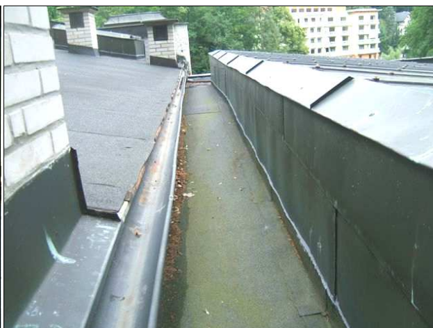
Foto 17/ Střecha 4 – Ukončení střechy u okapní hrany nad sousední střechou (5a)
