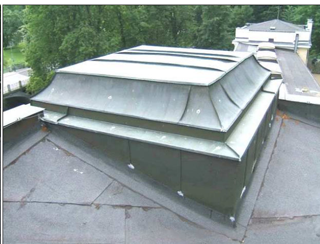
Foto /25/ Střecha 6 - Pohled na nároží střechy se čtvercovým vyzděným blokem
