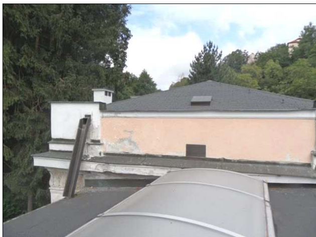
Foto /3/ Střecha 1 - Pohled na střechu - východní křídlo budovy
