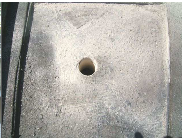
Foto /21/ Střecha 5b - Pohled na sondu do horního pláště střechy
