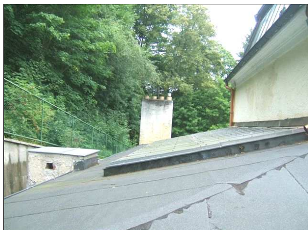
Foto 16/ Střecha 4 - Pohled na střechu
