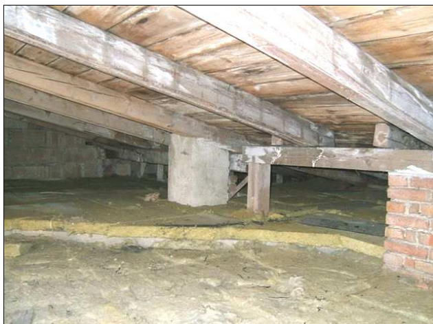
Foto /26/ Střecha 6 – Pohled do půdního prostoru střechy
