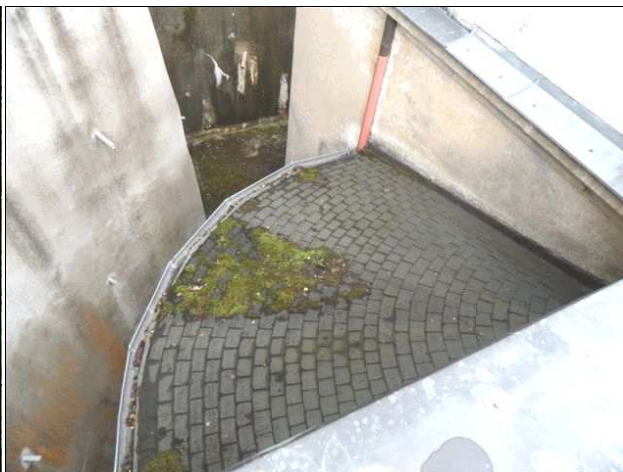
Foto /30/ Střecha 7 - Pohled na střechu (u hlavního sálu)
