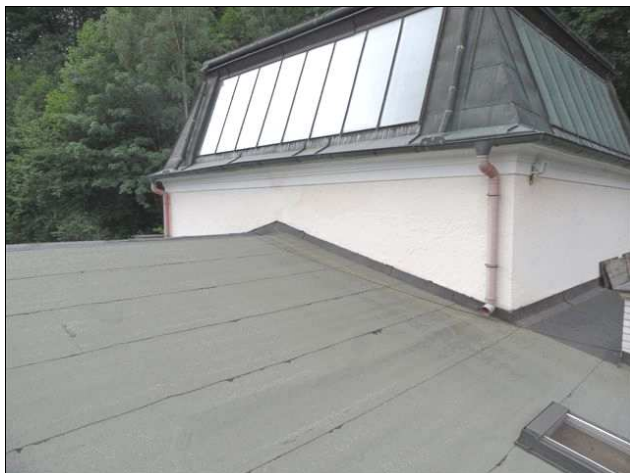
Foto /13/ Střecha 3 - Pohled na střechu
