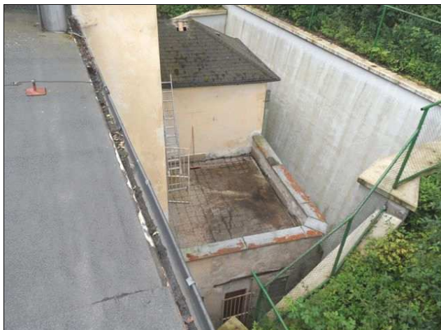
Foto /35/ Střecha 9 - Pohled na terasu
