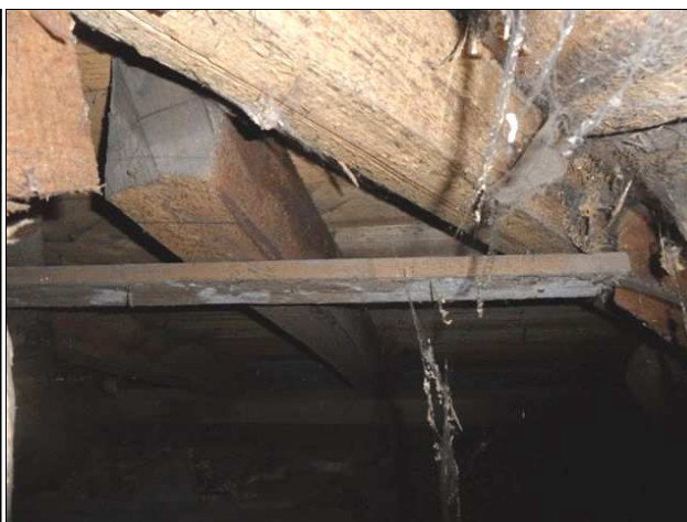
Foto /32/ Střecha 7 – Pohled do mezistřešního prostoru v místě sondy do horního pláště střechy
