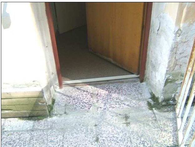
Foto /36/ Střecha 9 - Vstup na terasu
