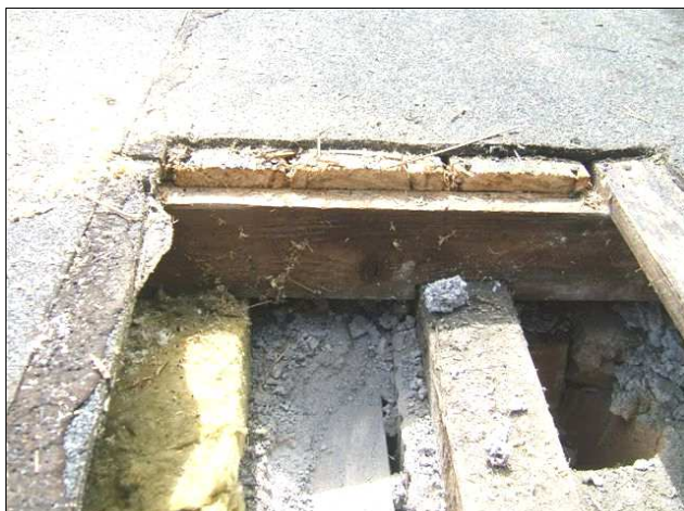
Foto /9/ Střecha 2 - Pohled na sondu do střechy – okraj střechy u podokapního žlabu
