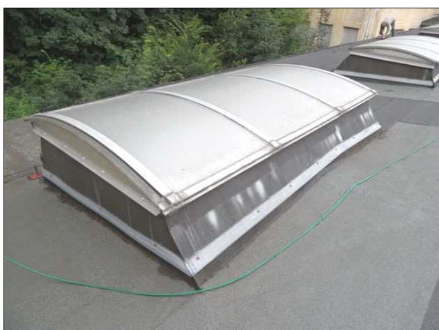
Foto /11/ Střecha 2 - Pohled na střešní světlík
