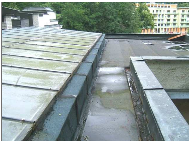
Foto /20/ Střecha 5a a 5b - Pohled na střechu
