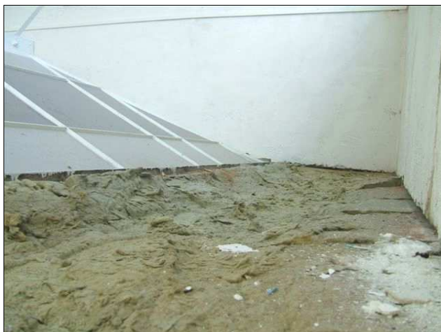
Foto /15/ Střecha 3 – Pohled na spodní plášť střechy
