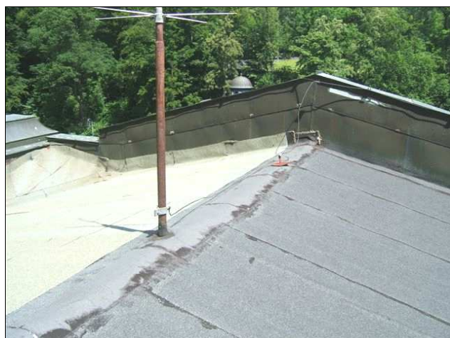
Foto /24/ Střecha 6 - Pohled na střechu
