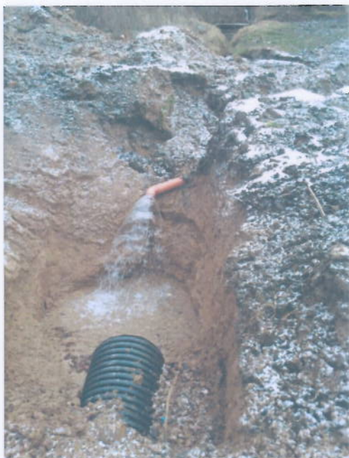
Obr. 2 Přítoky z povrchové vodoteče do prostoru stavby - dále k S zatrubněno (26.01. 2015)
