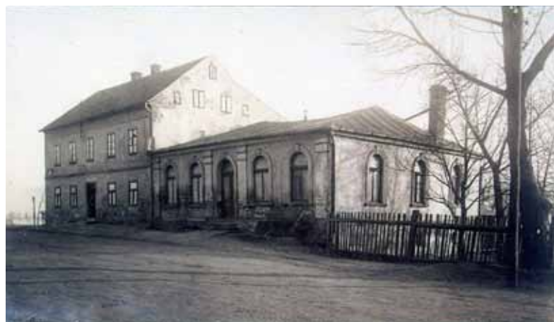
Počerny, dům č. 47 patřící k parní cihelně – foto z roku 1906
