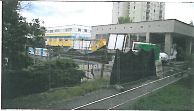
Zajištění staveniště bez závad.
