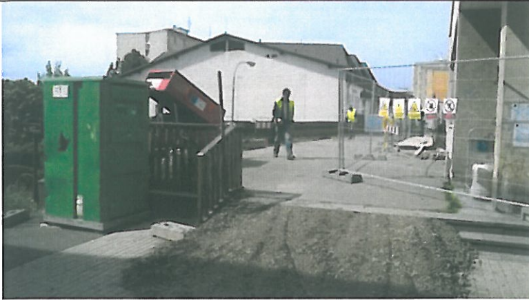
Zařízení staveniště a úprava schodiště – nájezd na stavbu.
