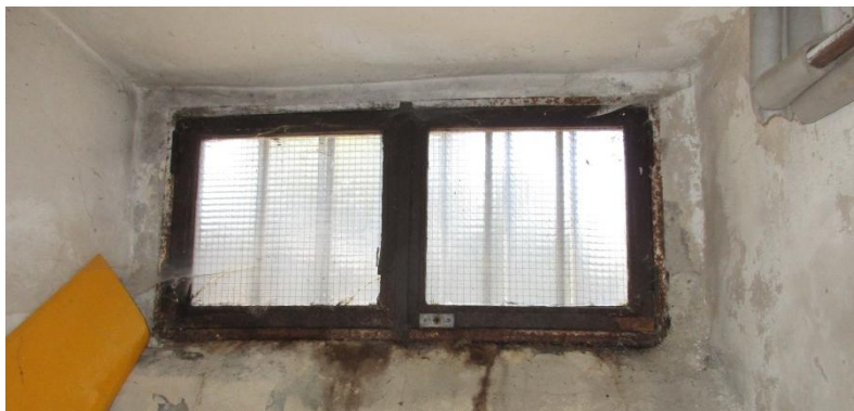
Okna schodiště do 1.pp
