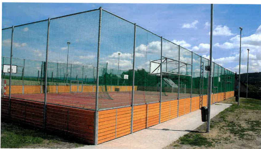
Oplocení se sítěmi a dřevěným mantinelem
