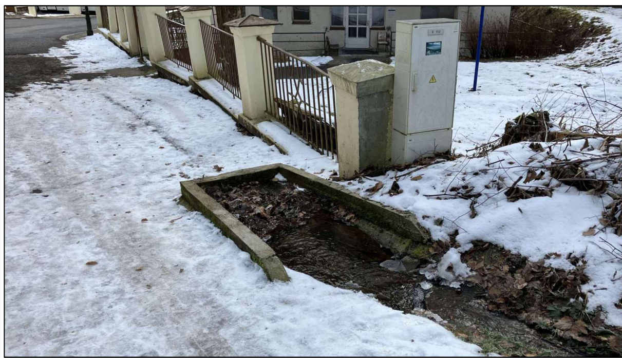
Obr. 4 Horské vpusti – zaústění vodoteče do kanalizace
