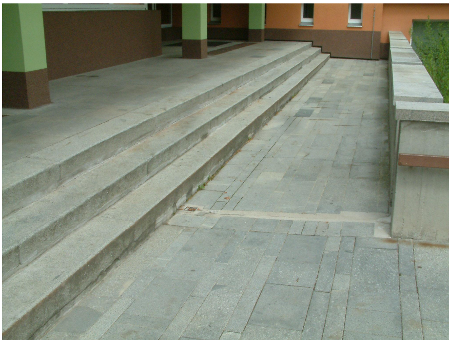
Vstup do školy s liniovým 3 stupňovým schodištěm
