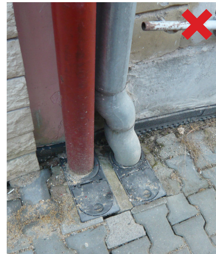
Obr. 9 Nejednotný a nevhodný detail okapního svodu
