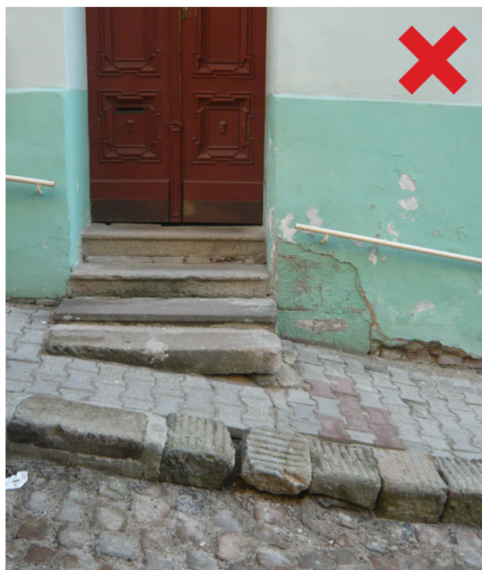
Obr. 10, 11, 12 a 13 Nevhodné řešení domovního vstupu, nejednotný design zábradlí a oplocení. V návrhu tyto prvky pokud možno zachovat a jejich design sjednotit.
