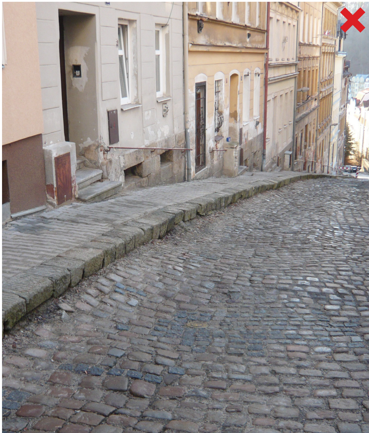
Obr. 1 Nevhovující uliční profil s příliš vysokým chodníkem, materiálová nejednotnost, domovní vstupy nenačuzující na chodník Obrubník řešit max. 100mm vysoký, sjednotit materiály - výchozím bude stávající kamenná dlažba vozovky.
