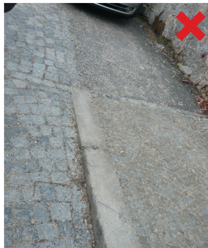
Obr. 4 Materiálová nejednotnost povrchů
