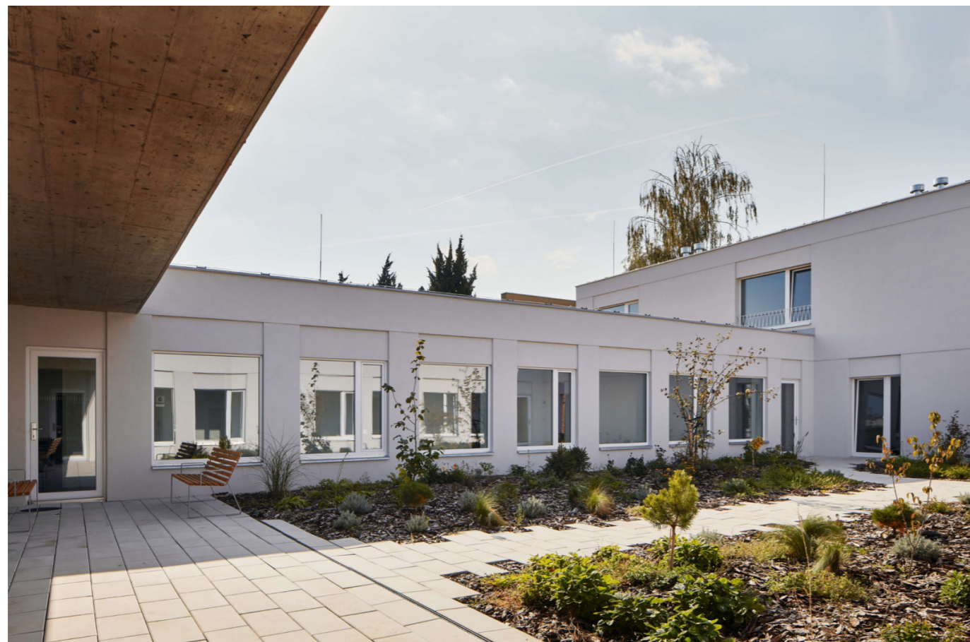
Referenční fotografie - Komunitní dům pro seniory v Křenovicích, Ondrej Palenčar, Adam Koten, Štěpán Vašut realizace 2022
