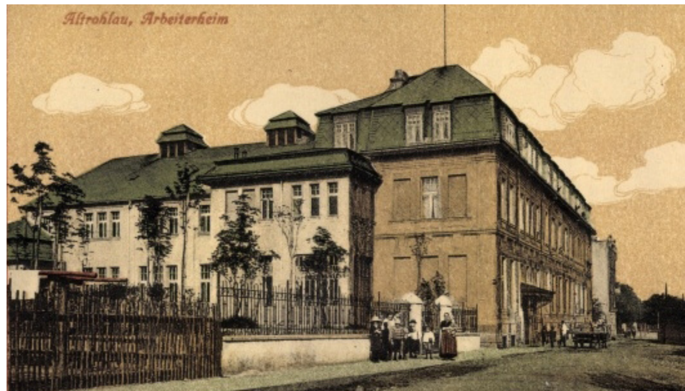
Kolorovaná historická fotografie Lidového domu - pohled z dnešní ulice Školní
