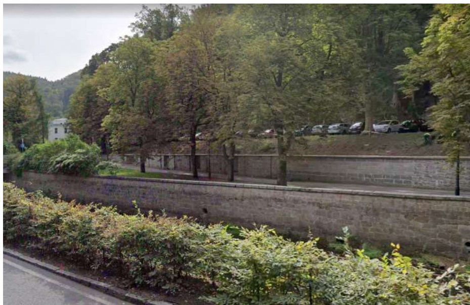
pohled na parkoviště z ulice Slovenská
