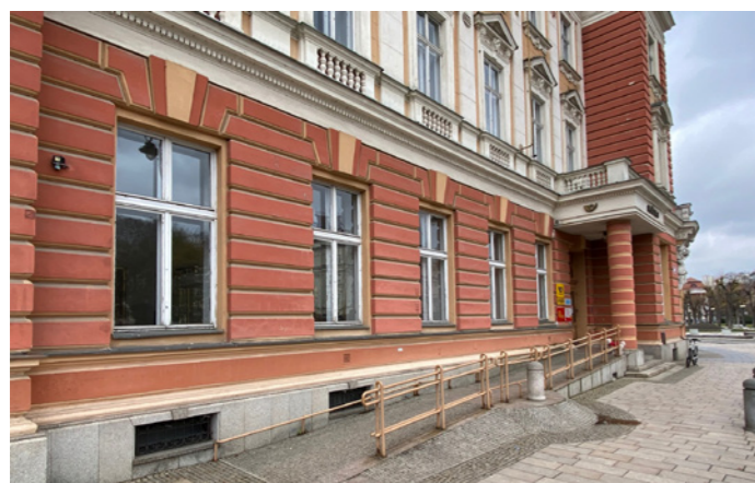
bezbariérový vstup z ulice Zahradní
