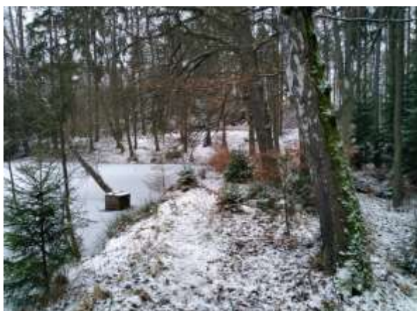
Foto 9: pohled na výpustné zařízení – otevřený požerák s poklopem
