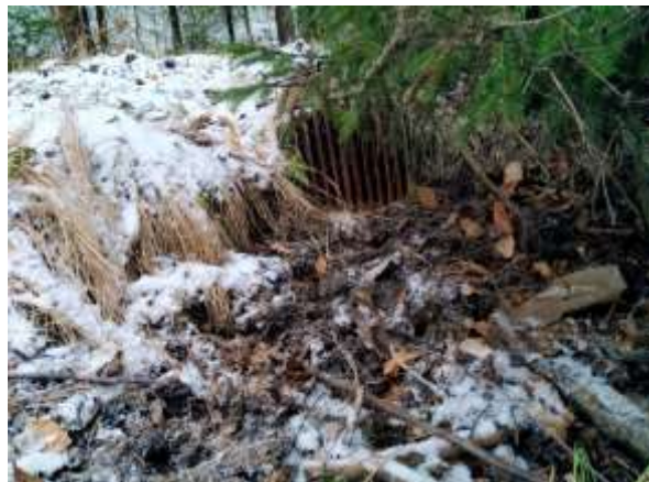
Foto 2: nátok do zatrubněného bezpečnostního přelivu u pravého zavázání hráže
