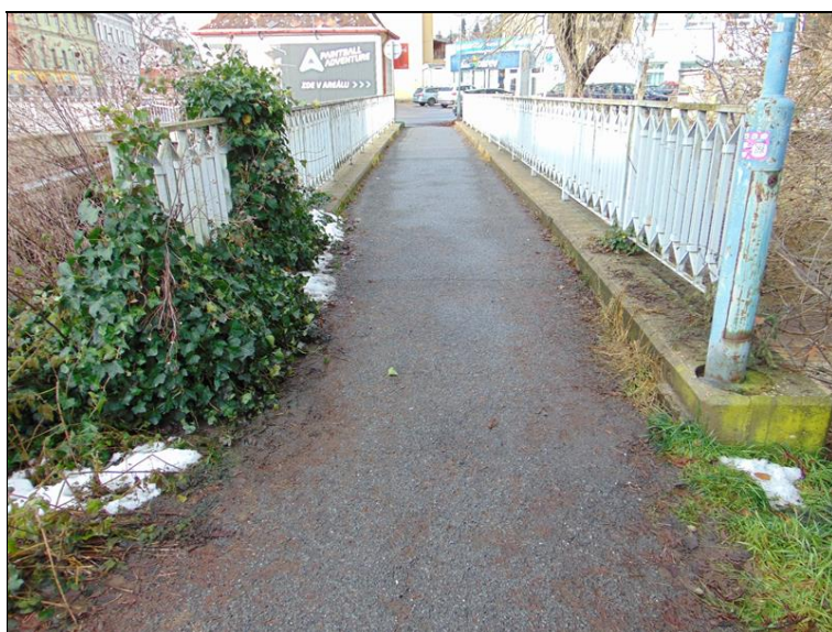
pohled proti směru staničení - předpolí a přechodová oblast nad levobřežní OP2
