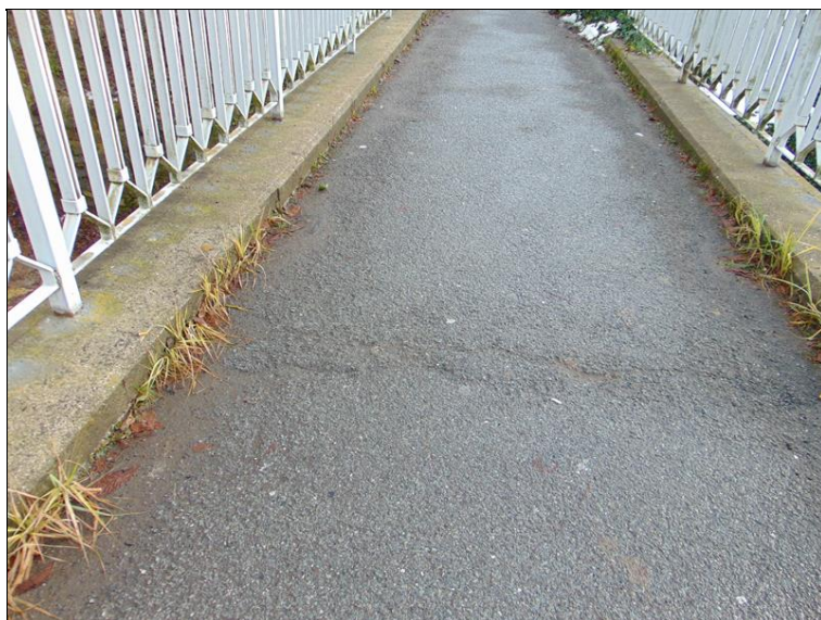
detail komunikace na lávce, vegetace u obrub (řřms)
