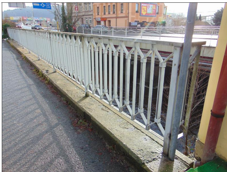
zábradlí na výtoku
