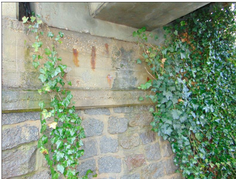
levobřežní OP2 - úložný práh
