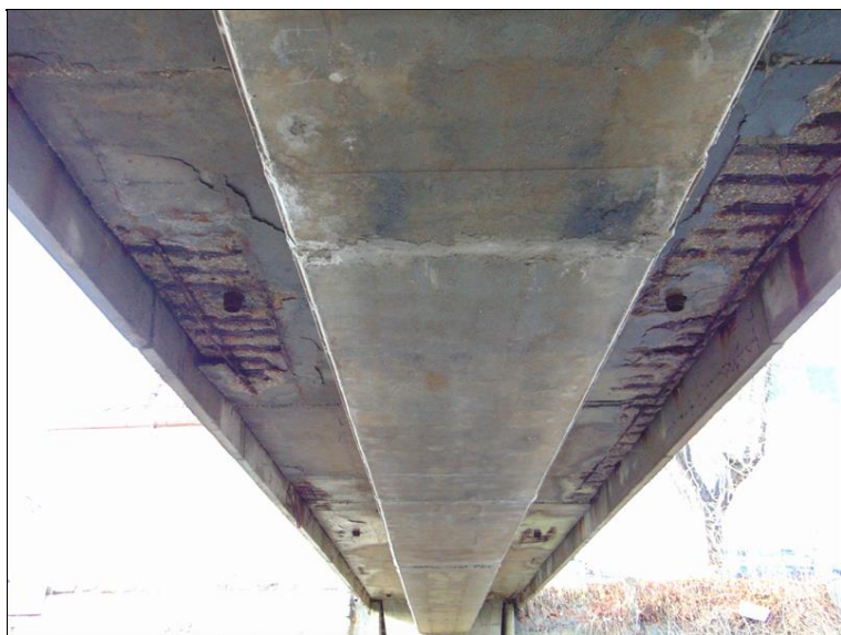
celkový podhled NK proti směru staničení - od OP2
