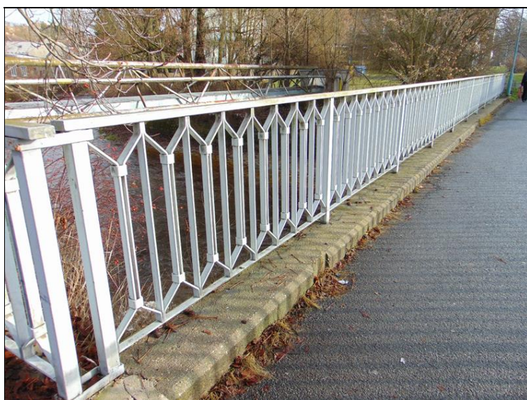
zábradlí na vtoku
