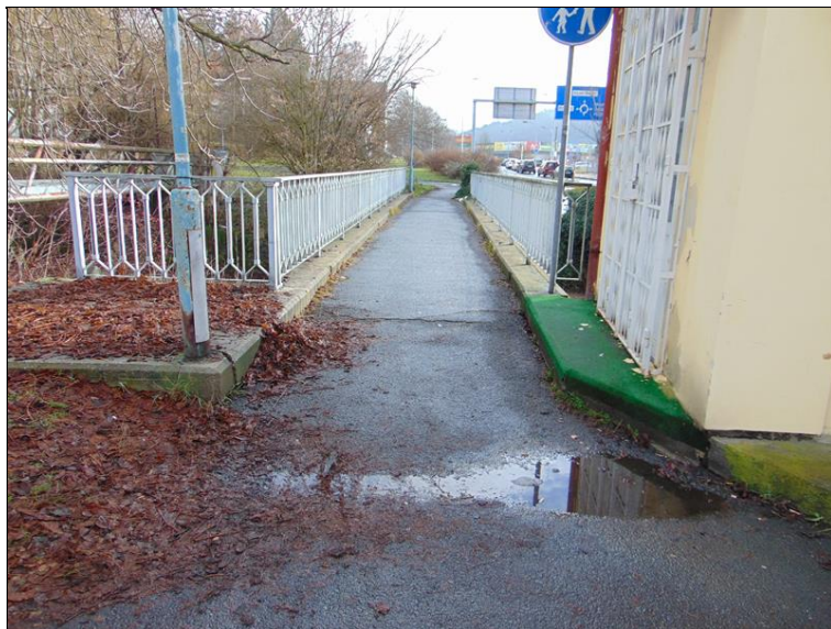
pohled ve směru staničení
