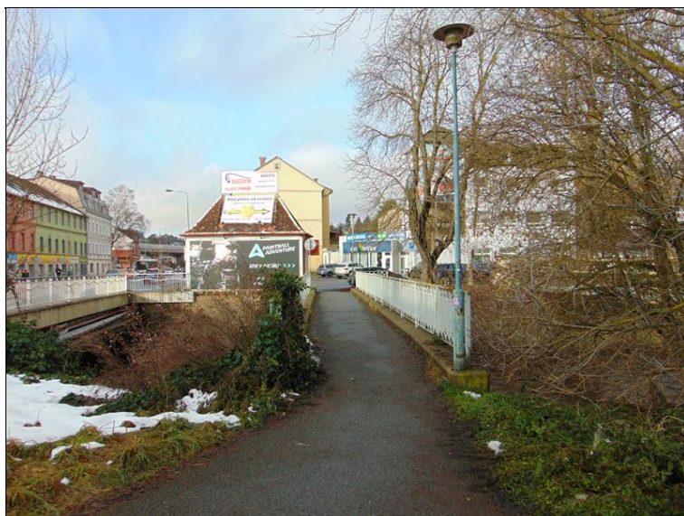
celkový pohled proti směru staničení
