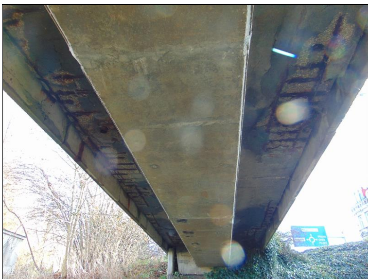
podhled NK ve směru staničení - k OP2
