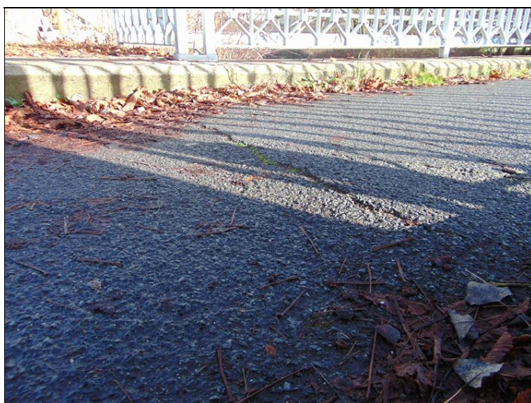
předpolí a přechodová oblast nad pravobřežní OP1 - oblast výraznějšího zatékání na opěru
