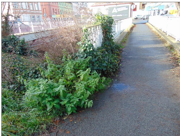
vegetace prorůstající zábradlím nad OP2 na výtoku
