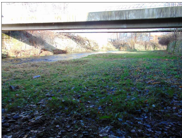
pohled do otvoru mostu proti směru toku - prostor koryta pod mostem
