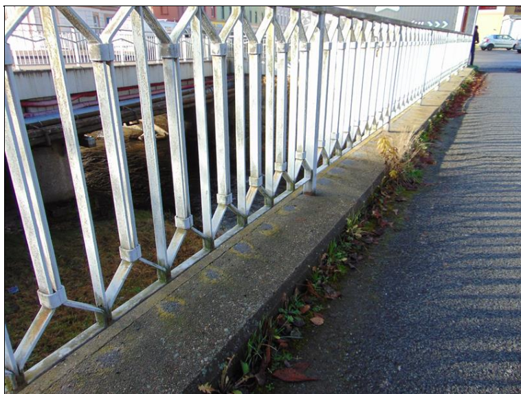
zábradlí a římsa na výtoku, vegetace u říms v komunikaci
