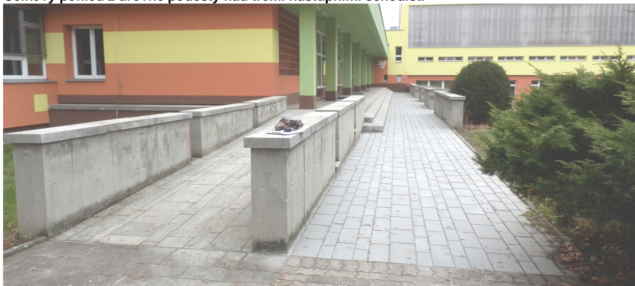
Celkový pohled z úrovně podesty nad třemi nástupními schodišti
