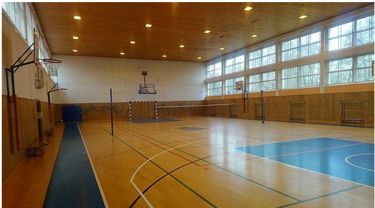
Pohled na okna v severní fasádě 2
