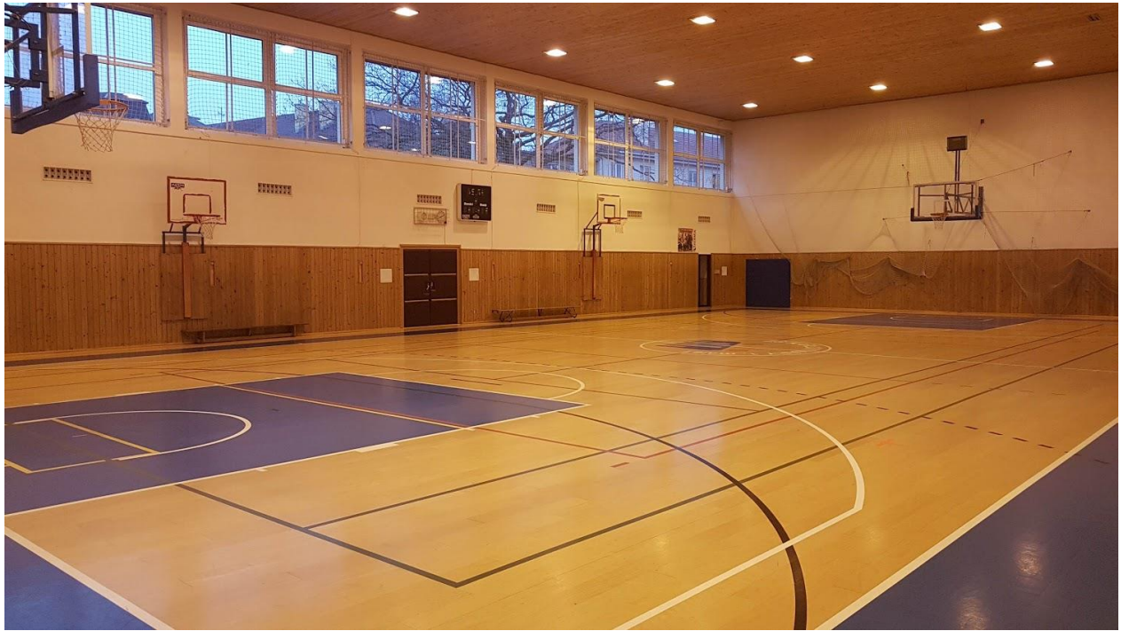
Pohled na okna v jižní fasádě 1
