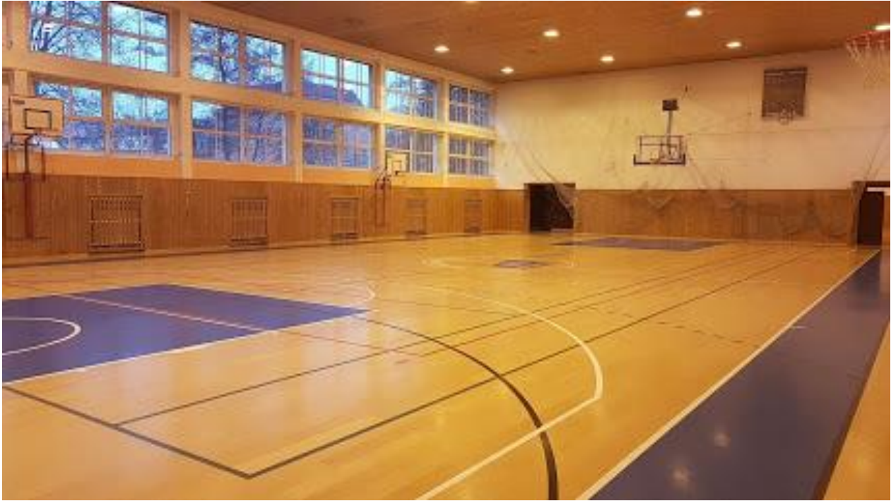
Pohled na okna v severní fasádě 1
