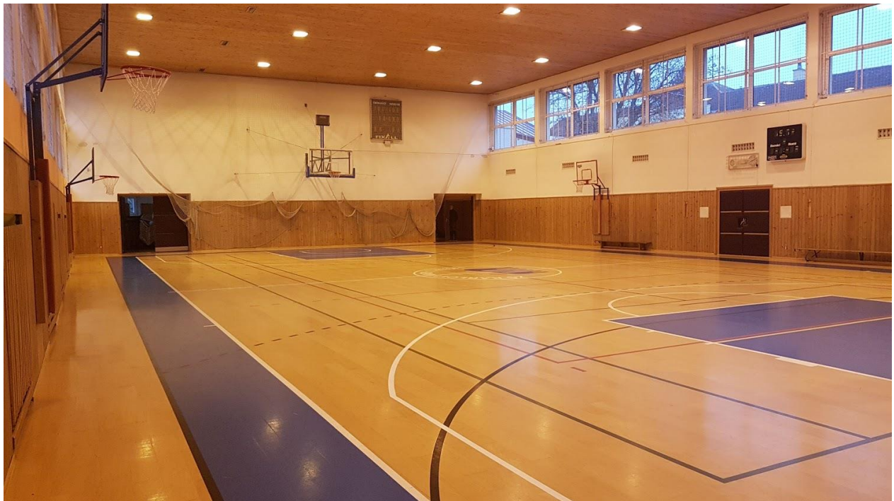
Pohled na okna v jižní fasádě 1
