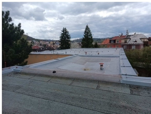
Foto /2/ Pohled na předmětnou střešní rovinu
