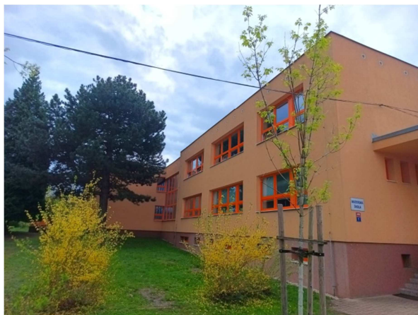
Foto /1/ Pohled na předmětný objekt
