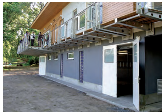
Rekonstrukce se nedávno dočkala také loděnice u Chebského mostu.
