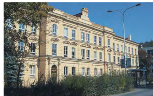
Většina karlovarských škol již prošla alespoň částečnou rekonstrukcí.
