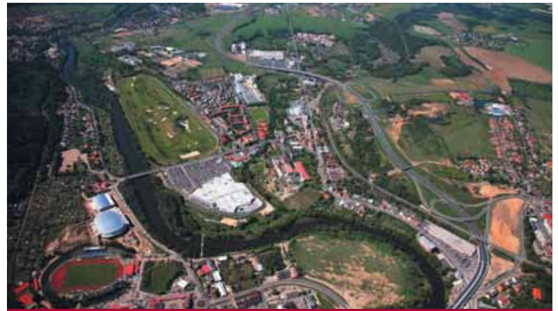
Rozestavěný sportovní a zábavní multikomplex (v levo dole) a jeho propojení na komunikace
