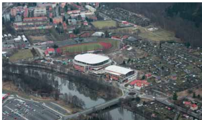
Poslední trapézový střešní plech i na hlavní halu – arénu (tréninková byla zatřešována jako první) byl připevněn v pátek 25.ledna 2008 přesně v 11:00 hod - více viz krátký článek na www.kvarena.cz
