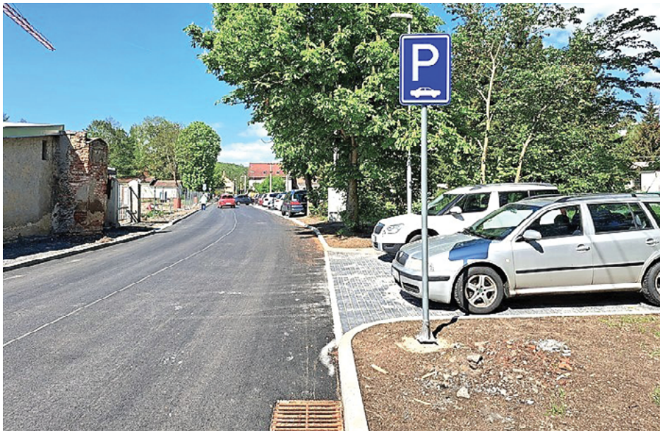
Parkovací zálivy v ulici Rolavská
