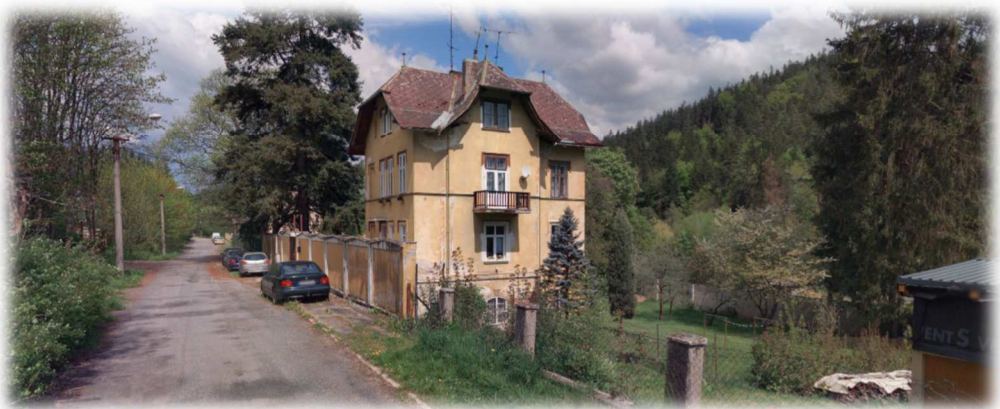
Obr.: S pohled na ul. K Přehradě s objekty, které představují hodnotu navazujícího území vůči transformační ploše T.8 o 2.NP s podkrovím s částečným podsklepením. Charakter těchto staveb je určující pro využití transformační plochy T.8.
