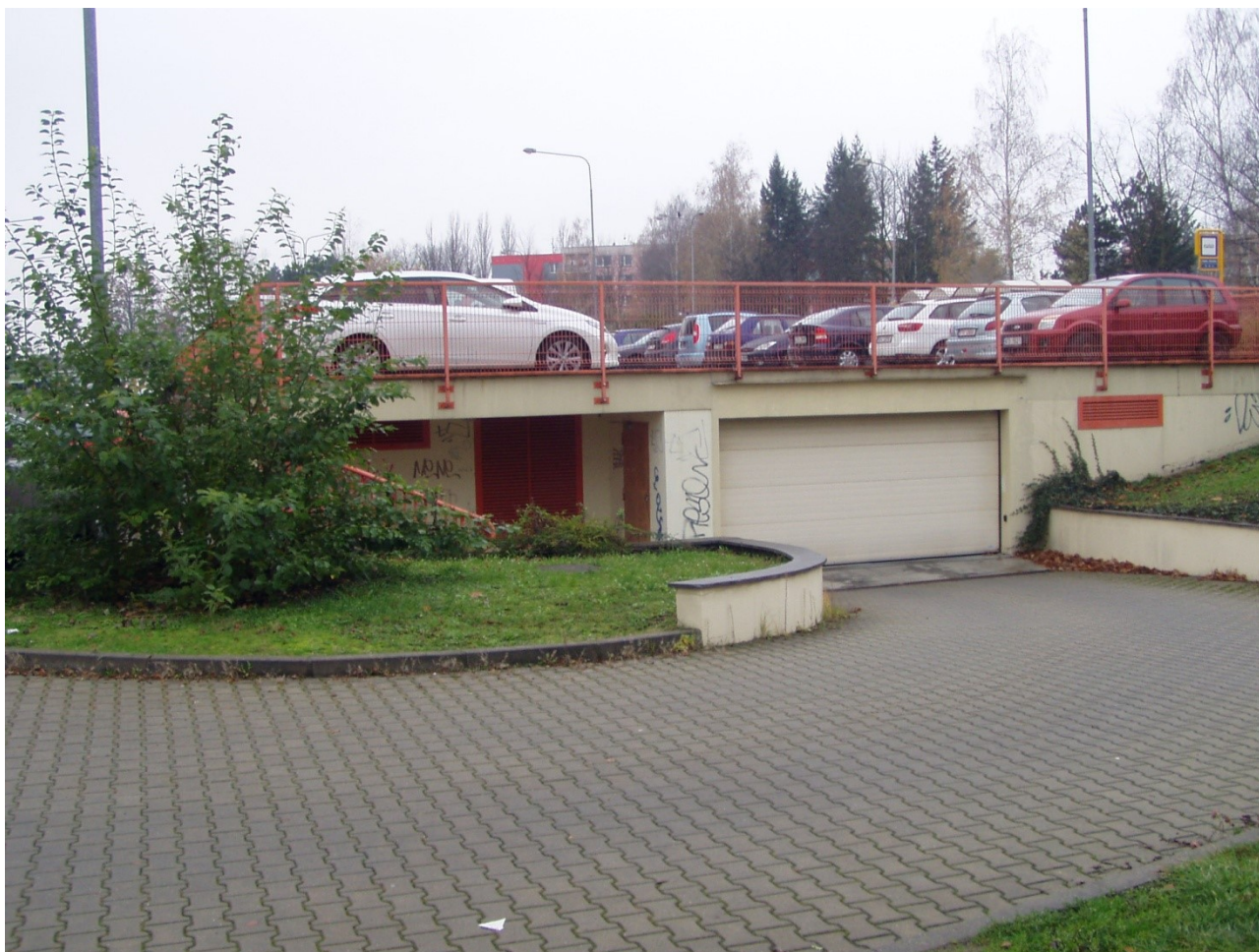
Obrázek 198: Dvoupodlažní napůl zapuštěná garáž s celkovou kapacitou 50 stání, Ostrava, ulice B. Nikodéma
