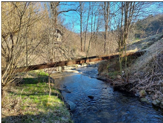
pohled z horní vody na objekt
