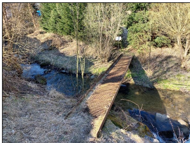
Celkový pohled na objekt
