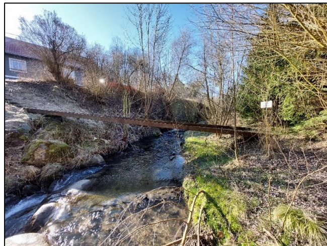
pohled z dolní vody na objekt
