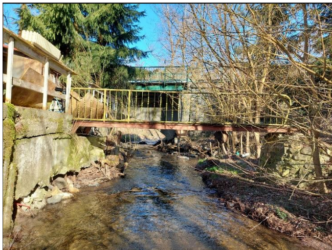
pohled z horní vody na objekt
