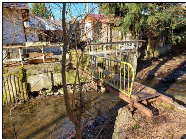
Celkový pohled na objekt
