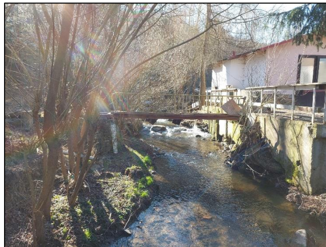
pohled z dolní vody na objekt
