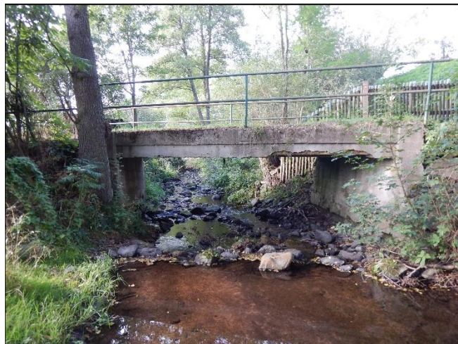
pohled z horní vody na objekt
