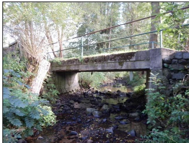
pohled z dolní vody na objekt
