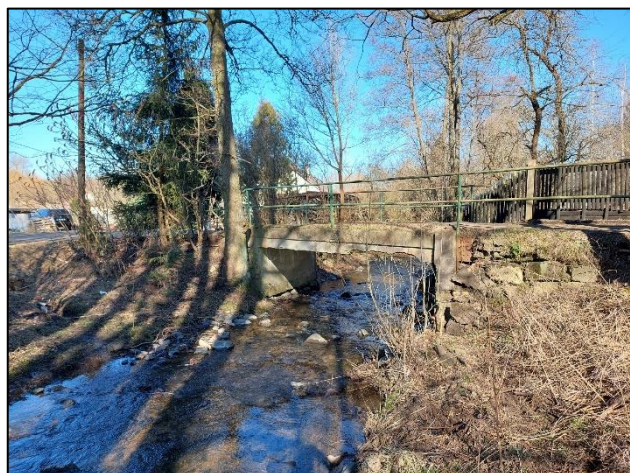
Celkový pohled na objekt
