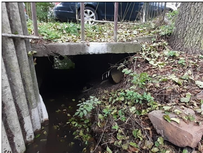
pohled z horní vody na objekt
