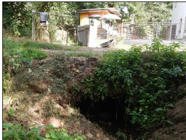
pohled z dolní vody na objekt
