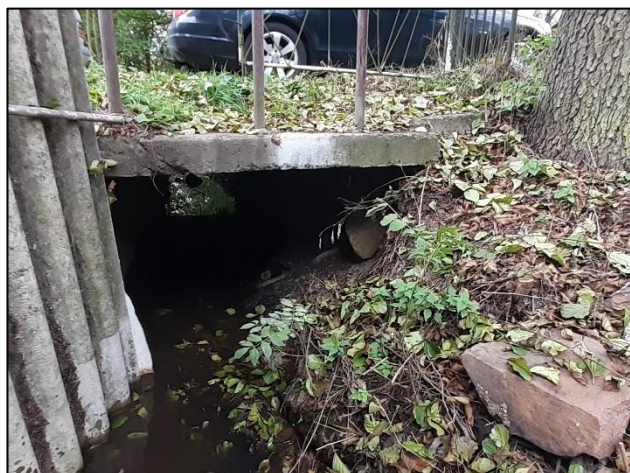
Celkový pohled na objekt
