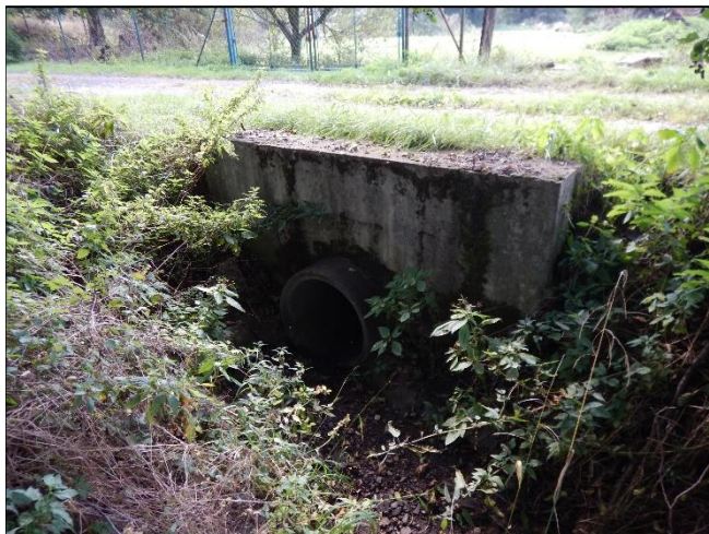
pohled z horní vody na objekt
