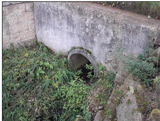
pohled z dolní vody na objekt
