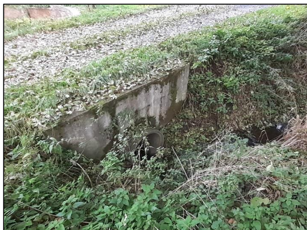
Celkový pohled na objekt
