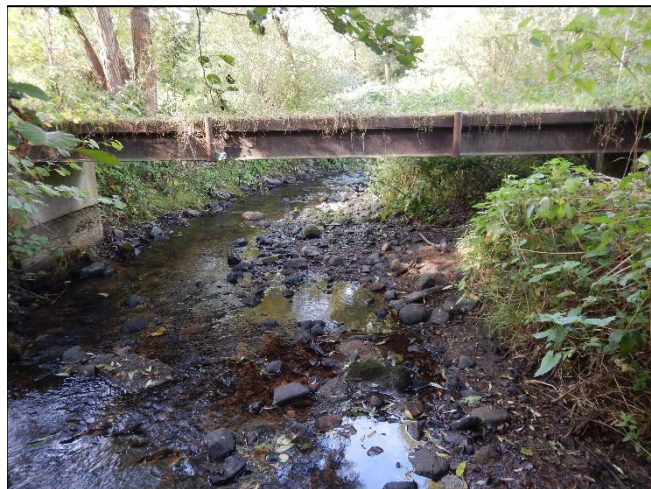
pohled z horní vody na objekt
