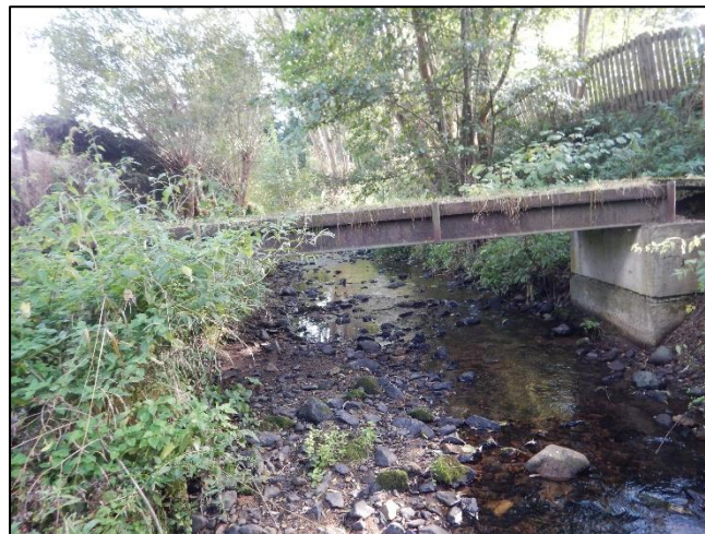
pohled z dolní vody na objekt
