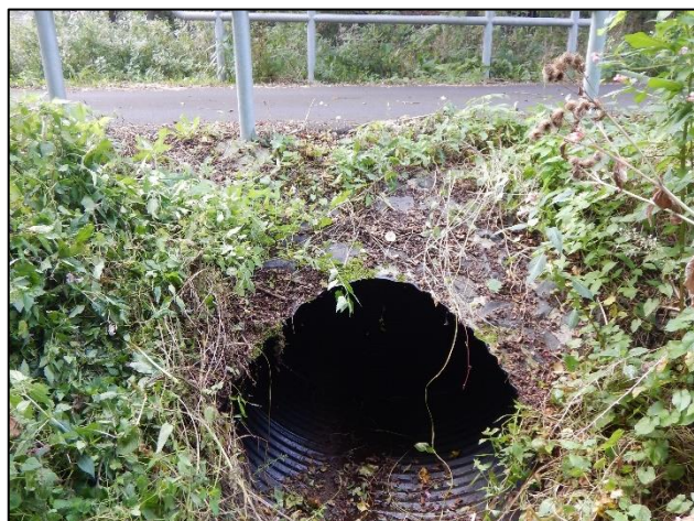
Celkový pohled na objekt
