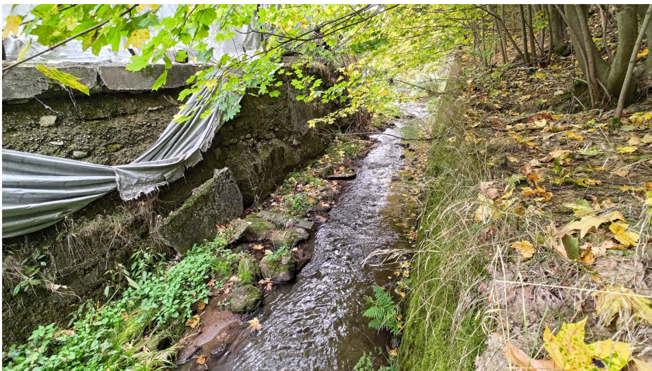
Obrázek 2 – Koryto nad soutokem s Rolavou – pohled po směru toku (ř. km 0,040)
