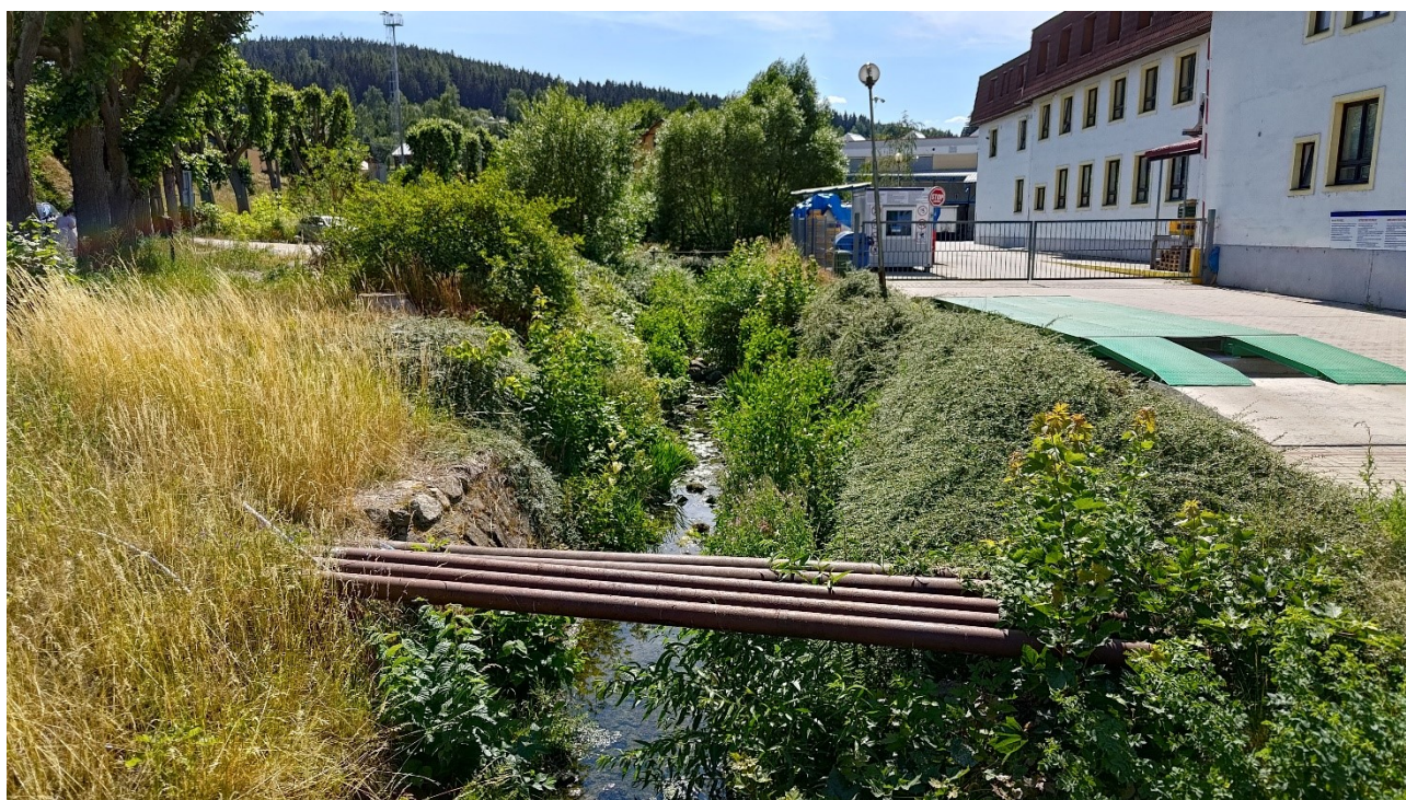
Obrázek 7 – Koryto nad vtokem do krytého profilu – pohled proti směru toku (ř. km 0,406)
