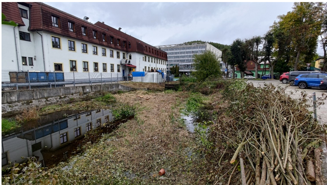
Obrázek 8 – Požární a okrasná nádrž Žába – pohled po směru toku (ř. km 0,480)
