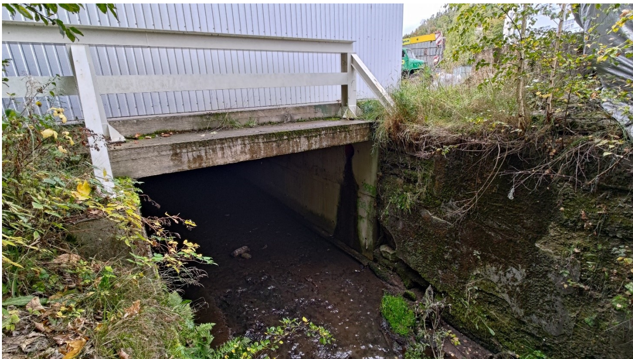
Obrázek 3 – Výtok z krytého profilu Rodišovky – pohled proti směru toku (ř. km 0,046)
