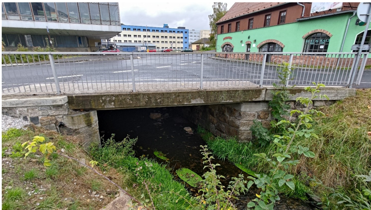
Obrázek 6 – Vtok do krytého profilu Rodišovky – pohled po směru toku (ř. km 0,406)
