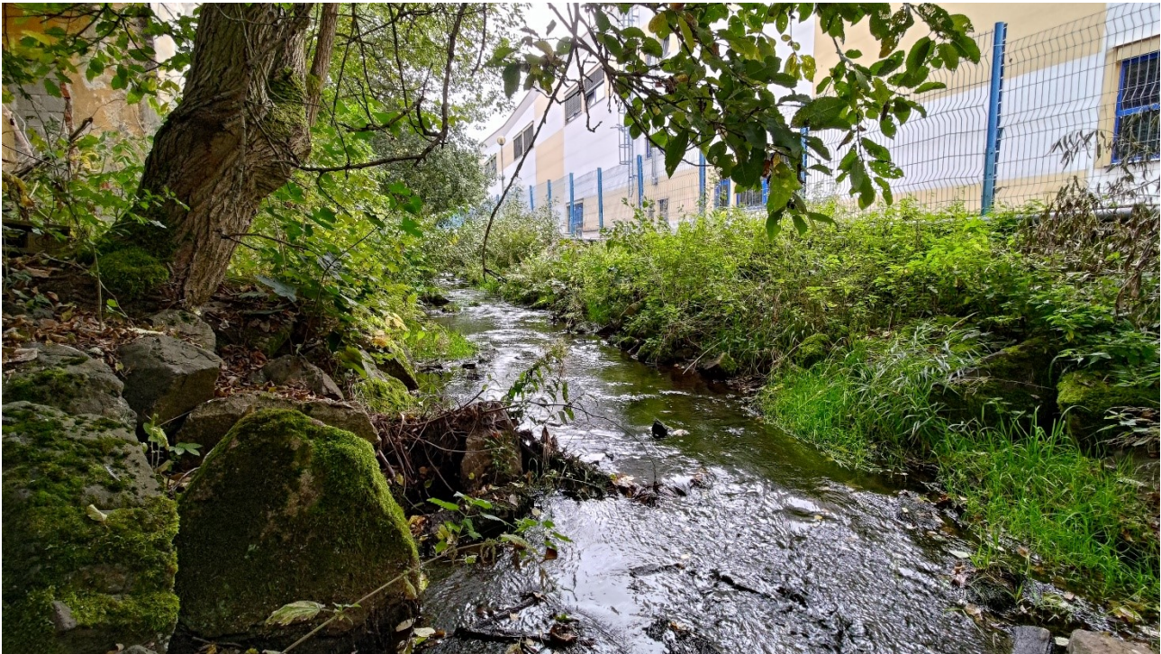
Obrázek 10 – Koryto u č.p. 517 – konec úseku, pohled proti směru toku (ř. km 0,560)
