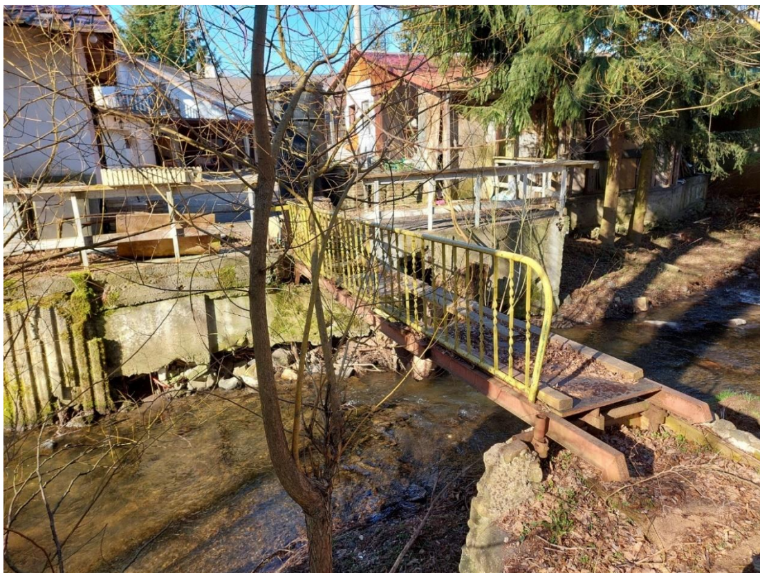
Obrázek 8 Lávka PF_4_L (ř. km 0,086) a objekty na levé břehové hraně
