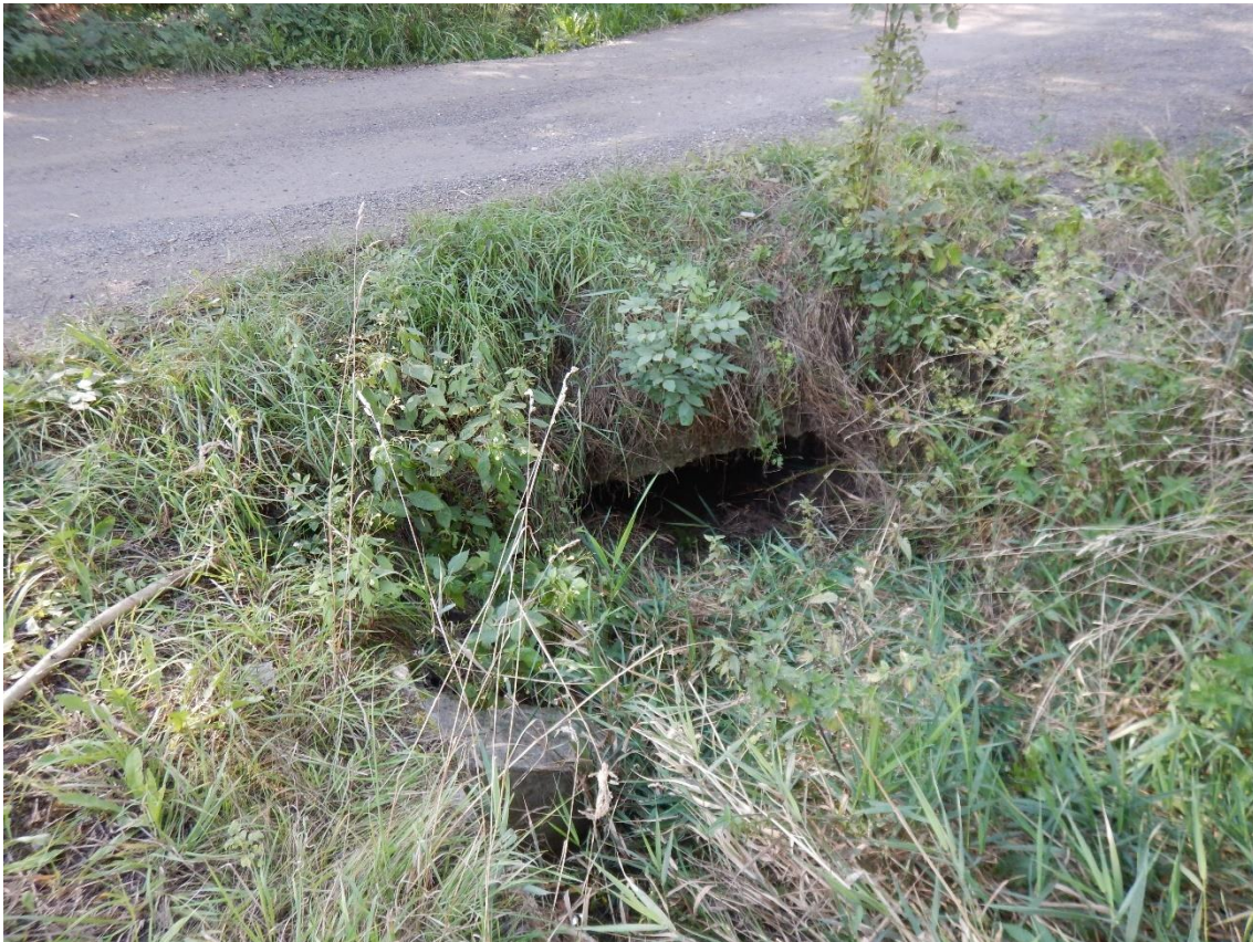
Obrázek 10 Nekapacitní mostek PF_29_M (ř. km 3,272)
