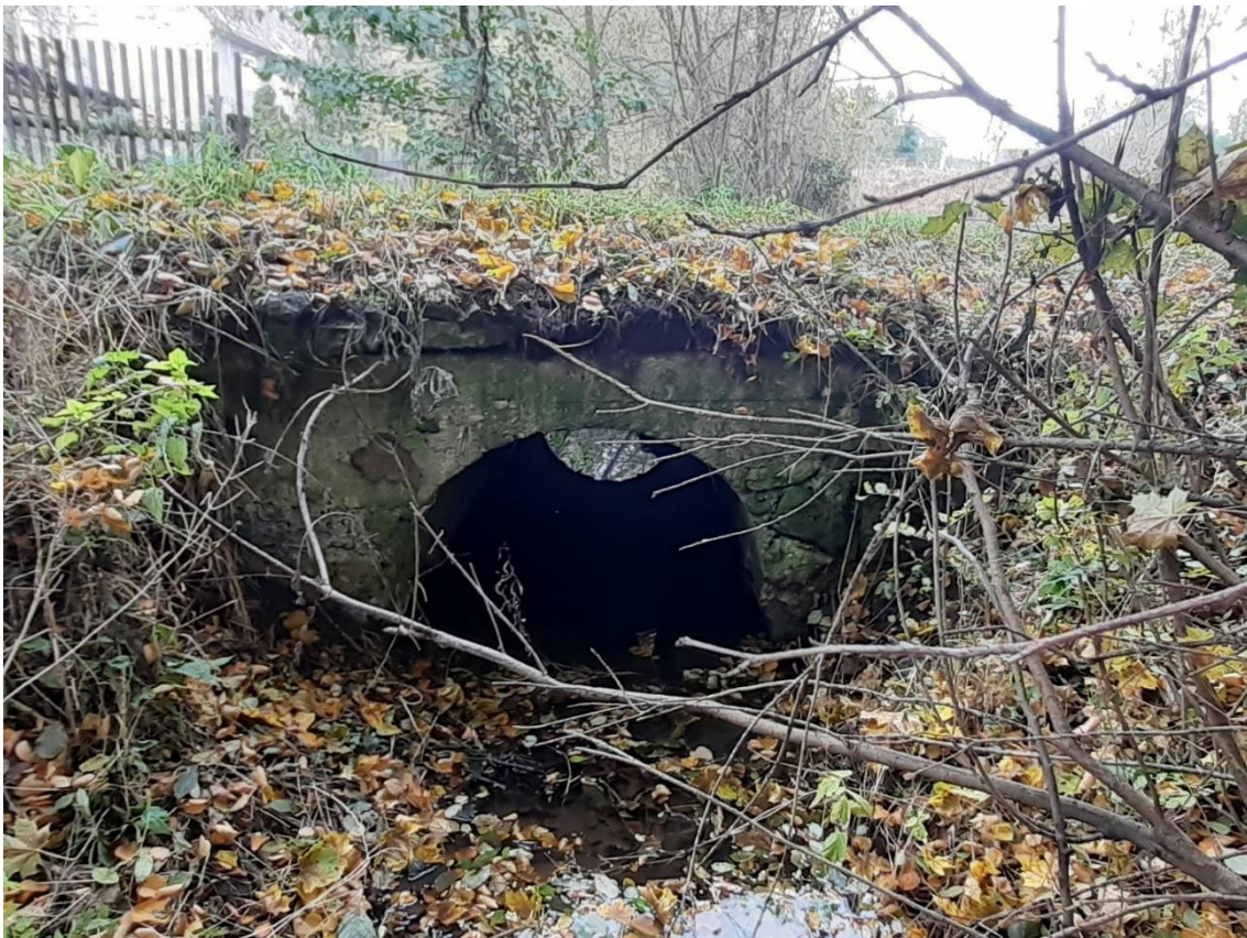
Obrázek 9 Nekapacitní mostek PF_22_M (ř. km 2,765)
