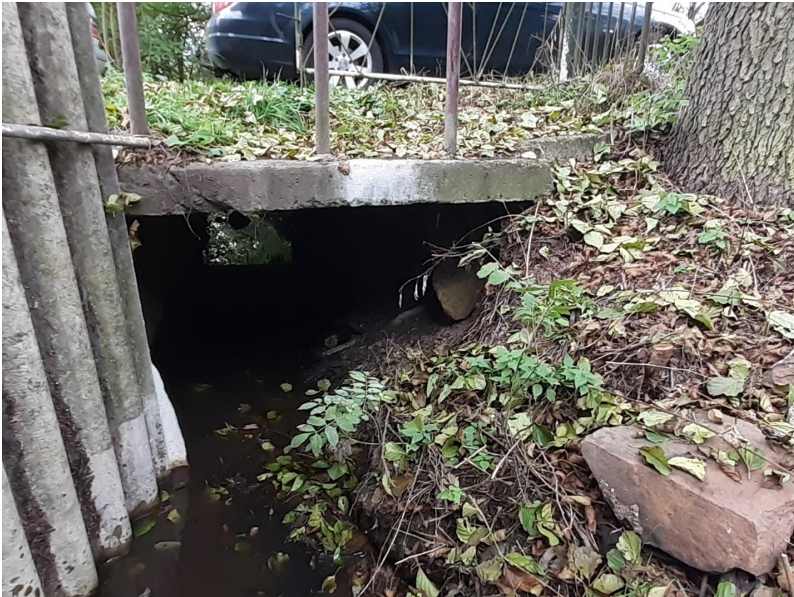
Obrázek 9 Nekapacitní mostek PF_22_M (ř. km 2,765)
