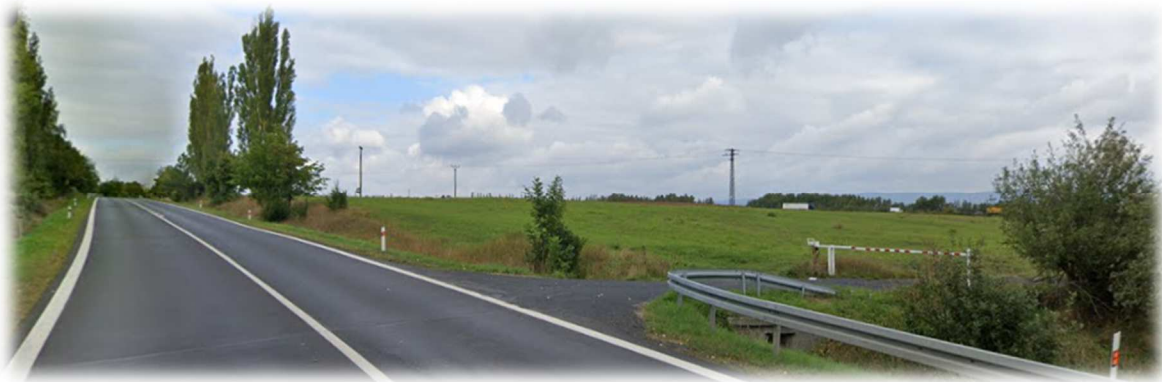
Řešené území od jihu ze silnice I/20
