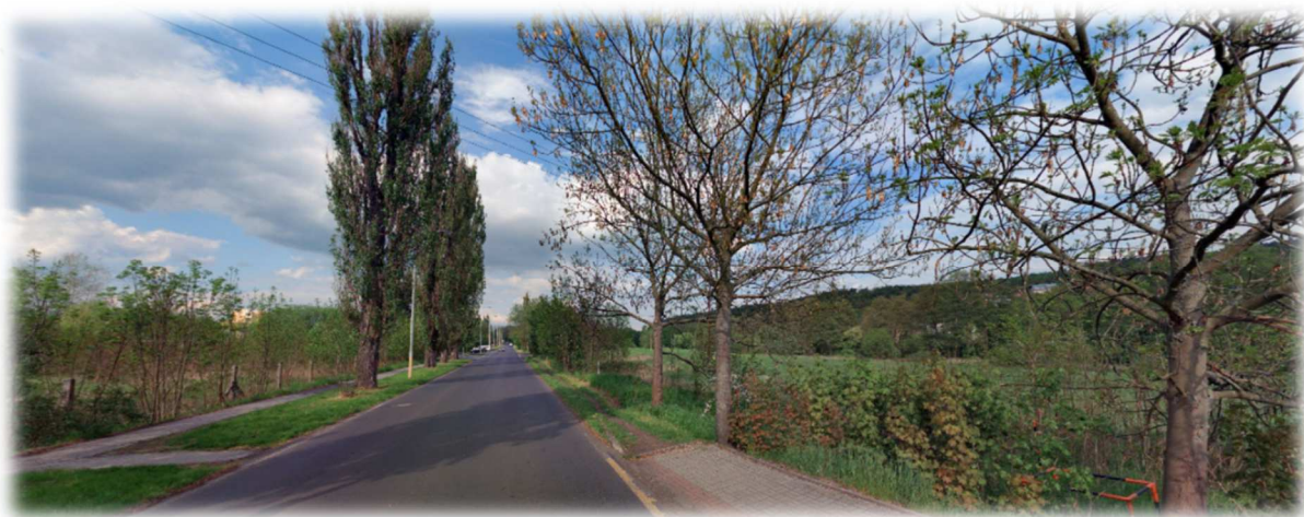
Obr.: Stávající stav ulice Závodní, vpravo navazující údolní niva Ohře nebrání rozšíření vstupní
