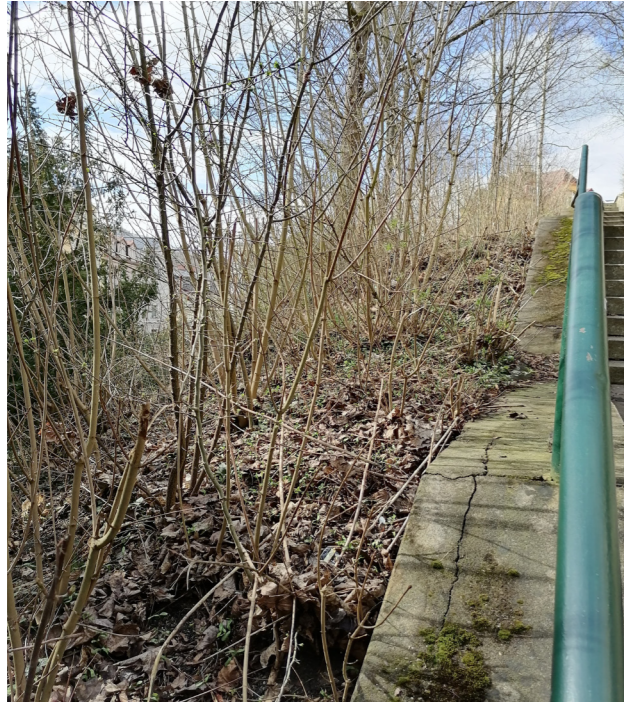
Podél jižní stany schodiště je betonová obruba s trubkovým zábradlím.
