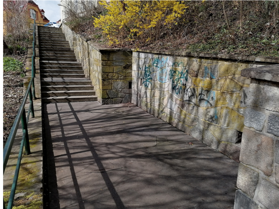
Plochy podest mezi schodišťovými rameny jsou vyasfaltovány.
