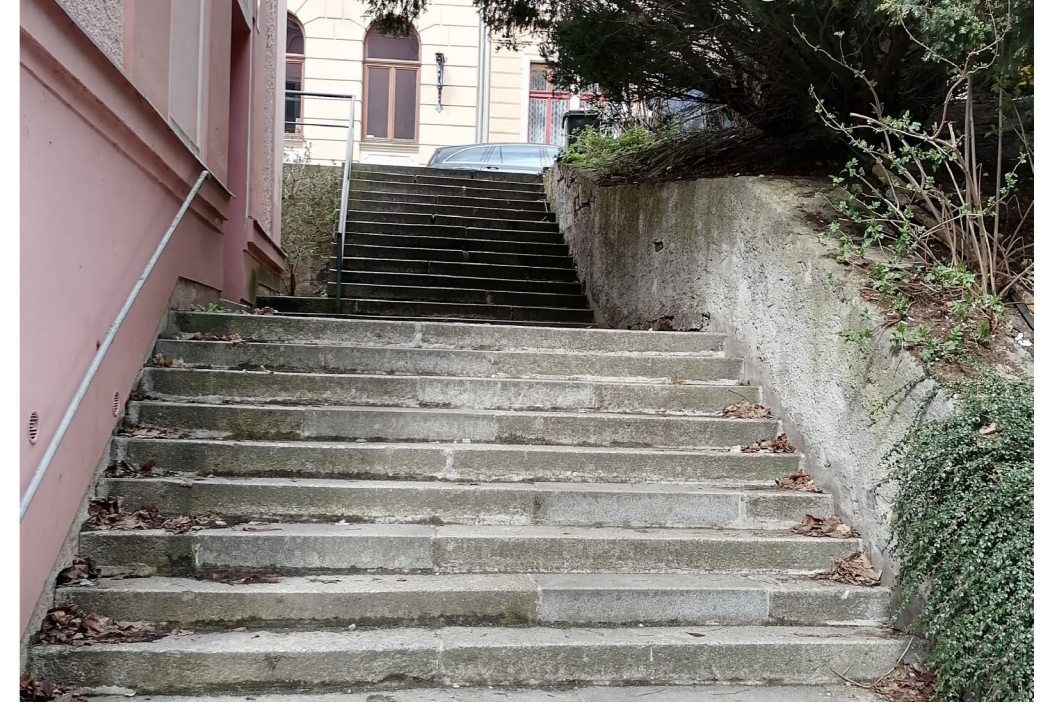
Na plochu zeleně navazuje schodiště v poměrně dobrém technickém stavu.
