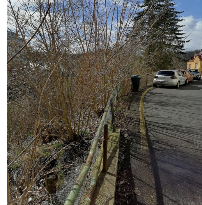
Schodiště vede do ulice Petřín, kde navazují parkovací místa.
