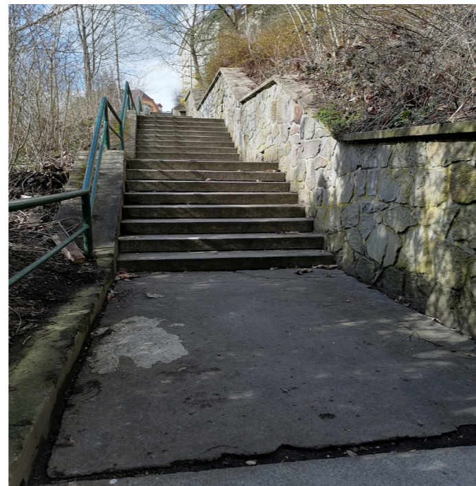
Opěrná zeď je v dobrém technickém stavu.
