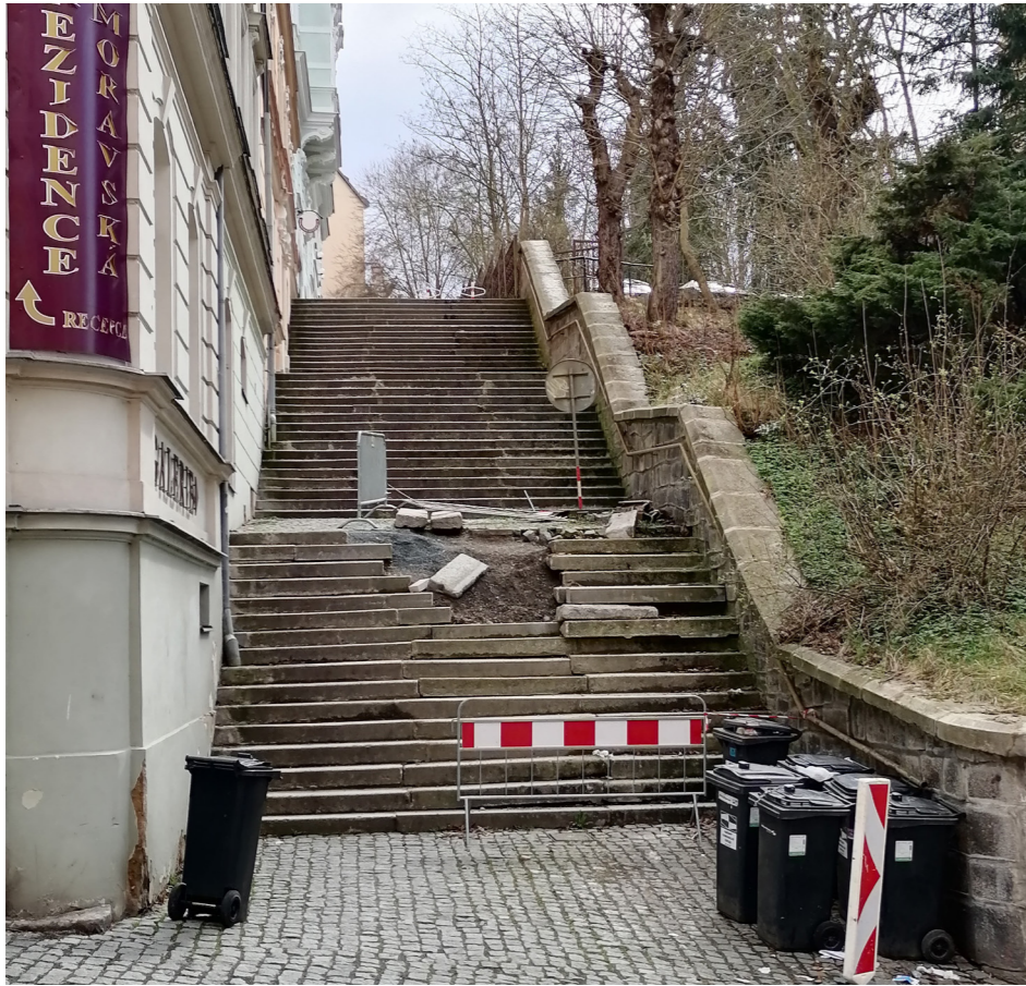
Kamenná opěrná zeď je dobrém technickém stavu a nevyžaduje opravy.
